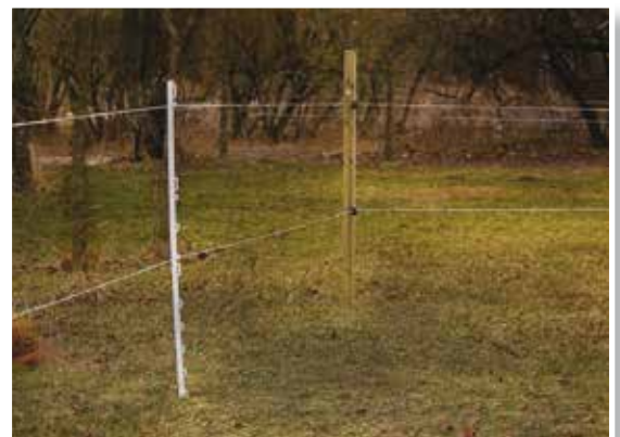
Bilde 1. Spenn en tråd mellom hjørnestolpene.
