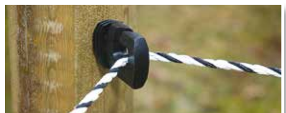
Bilde 2a. Isolatorene plasseres diagonalt på hjørnestolpen. Her for tråd/tau.
