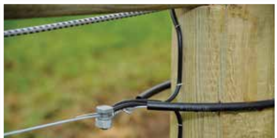
Bilde 23. Sikker trådkobling fra apparat til gjerde.
