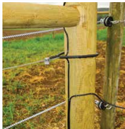
Bilde 22. Tråd kobles med strømkabel og trådskjøt.
