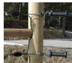
Bilde 15. Bruk gripper , 86674702 når du skjøter.
