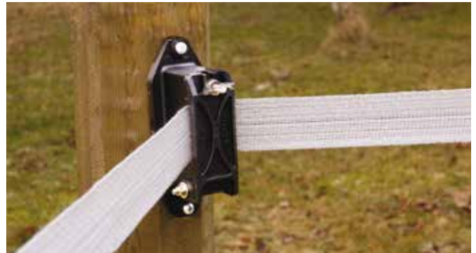
Bilde 4. Isolatorene settes diagonalt på hjørnestolpen.
