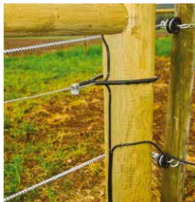
Bilde 21. Tråd kobles med strømkabel og trådkjøt.
