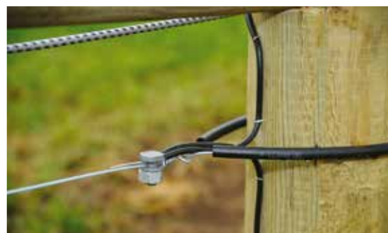
Bilde 22. Sikker trådkobling fra apparat til gjerde.
