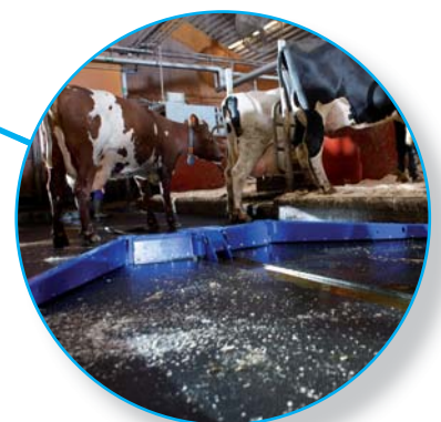
Скреперные системы навозоудаления
