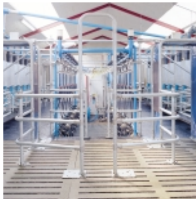
Overzicht van de DeLaval visgraatmelkstal 50°.
